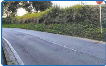
誘導標設置前 土砂撤去前
