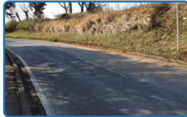
誘導標設置前 土砂撤去
